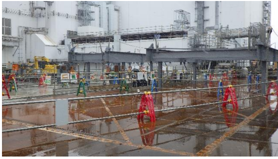
(写真3-3) 2号機原子炉建屋南側ヤードの概観② (今回(令和5年2月10日) 南側から撮影)
