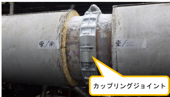
(写真1-2) カップリングジョイントの状況 (東側から撮影)
