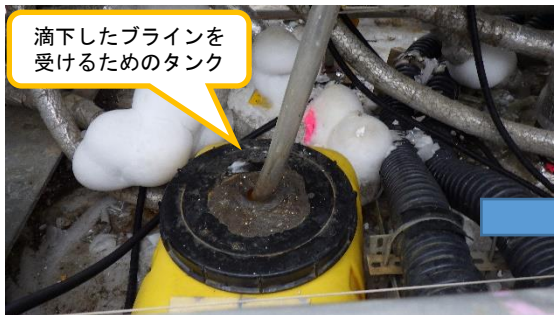
(写真2-1) ブライン滴下箇所下部の状況 (前回 (令和5年2月3日) 東側から撮影)
