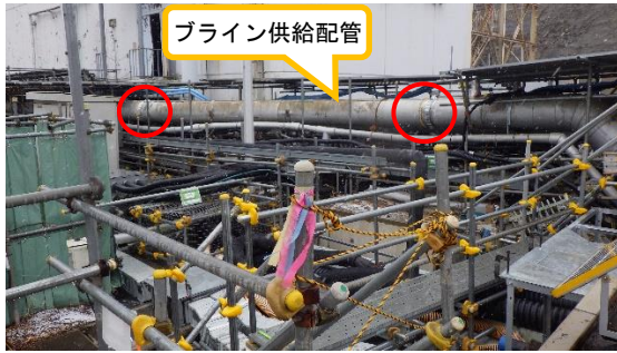
(写真1-1) ブライン供給配管取付の状況 (北東側から撮影) ※赤丸の箇所が交換するカップリングジョイント部で右側の赤丸の箇所が令和4年11月28日にブラインの滴下が確認されたカップリングジョイント部
