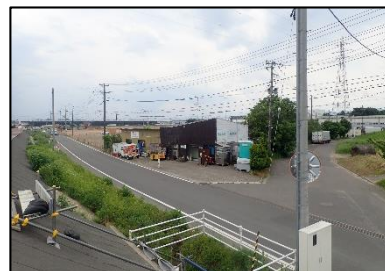
②堤内地状況
