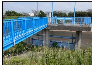
②排水樋門(横塚ポンプ場)
