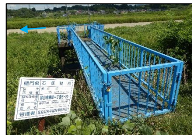
③石塚排水樋門
