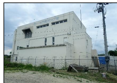
①水門町ポンプ場
