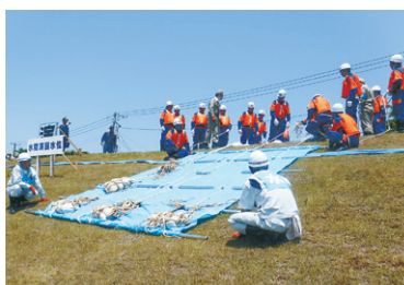
シート張り工法
