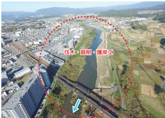
夏井川3工区(平鎌田地内) 施工前
