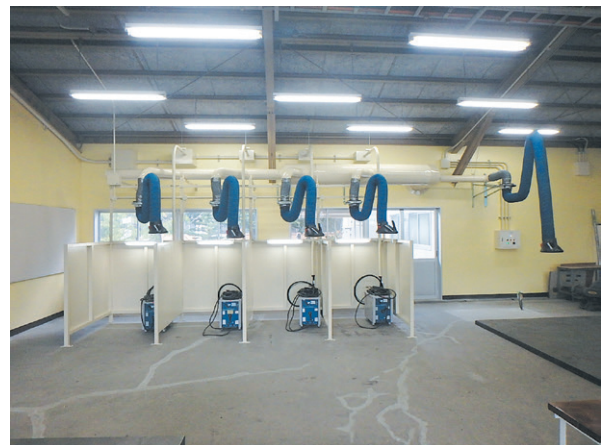
平工業高校溶接実習室局所排気設備工事
