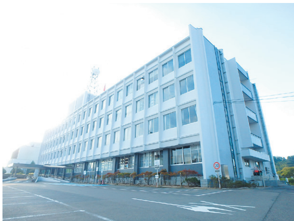
いわき合同庁舎外壁改修工事
