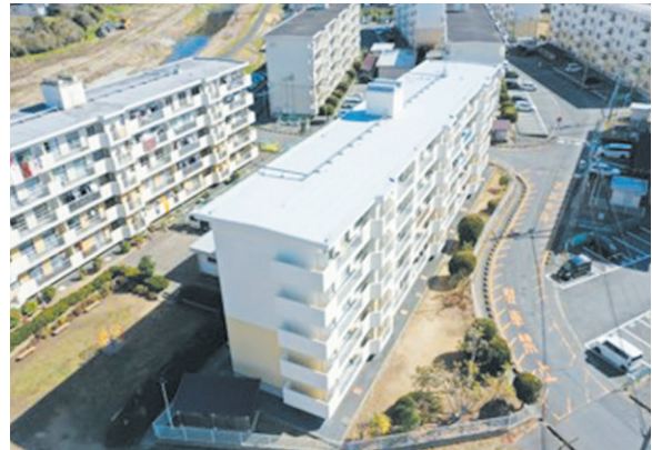
叶田団地 7号棟外壁改修工事（改修後）
