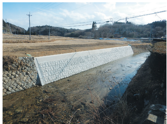
小玉川（三和町差塩）復旧完了
