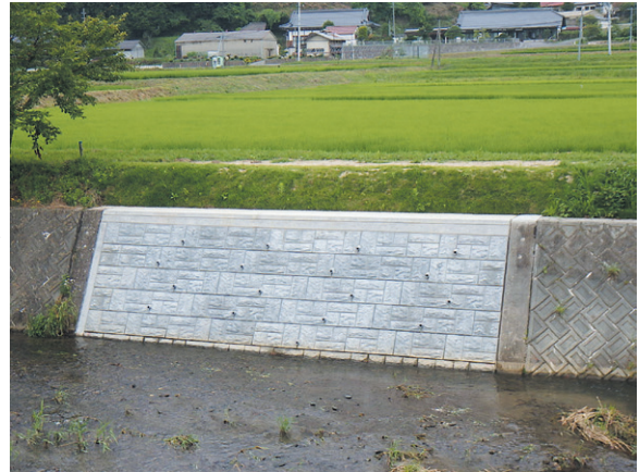
三坂川（三和町中三坂）復旧完了
