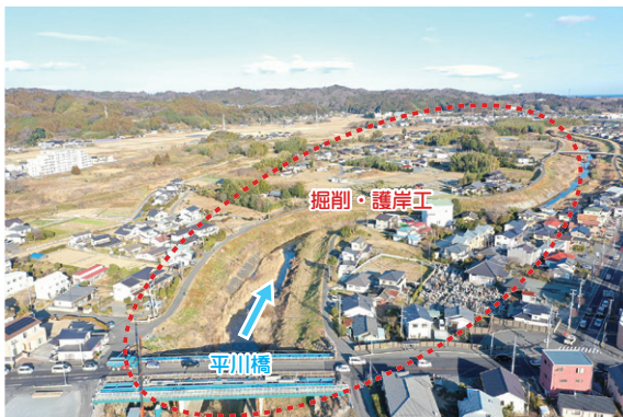
好間川1工区(平北目町地内) 施工前
