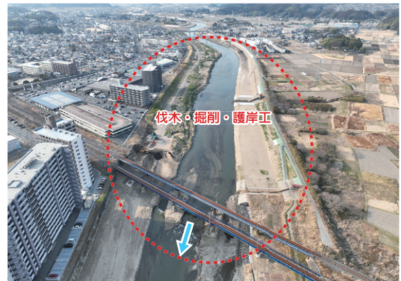
夏井川3工区(平鎌田地内) 掘削・護岸工を施工中
