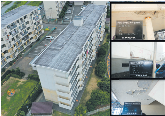
叶田団地 7号棟外壁改修工事（改修前）
