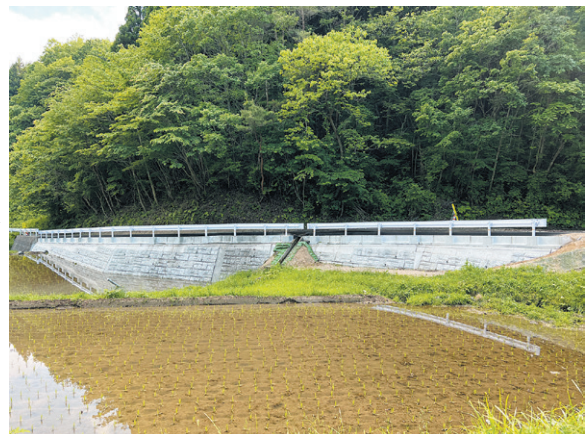
三株下市萱小川線（三和町下市萱）復旧完了
