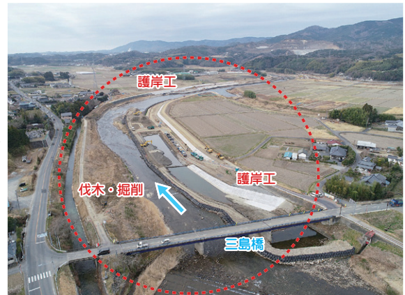
夏井川14工区(小川町三島瀬棚地内) 掘削・護岸工を施工中
