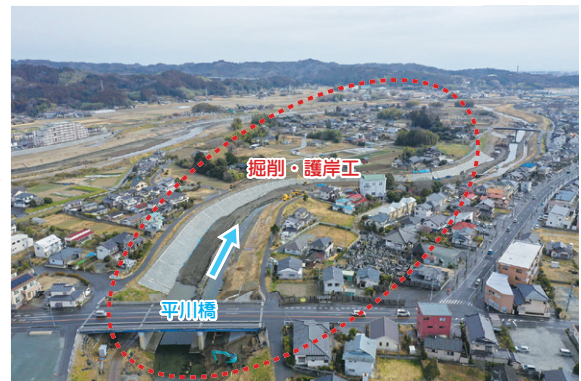
好間川1工区(平北目町地内) 掘削・護岸工を施工中
