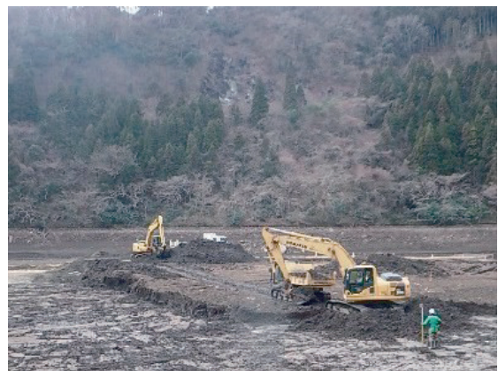
【高柴ダム】堆砂除去作業状況
