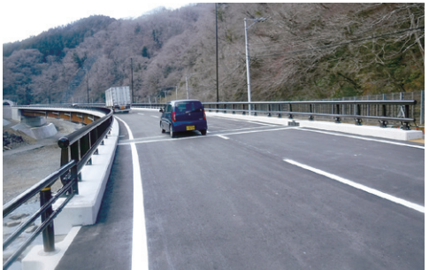
いわき石川線 ※物流を支援する道路
