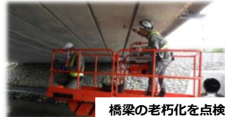
橋梁の老朽化を点検
