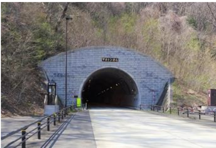
【甲子トンネル西郷側坑口】
