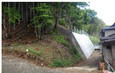
【樋ノ口2号（白河市）】
