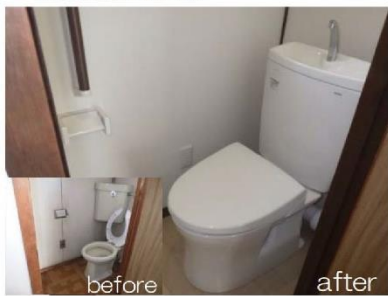
①トイレの段差解消・便器更新・手すり設置
