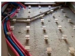
②③⑤浴室・洗面所・台所へ給湯配管設置
