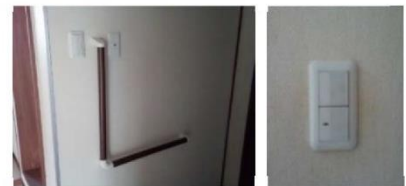
④玄関へ手すり設置
