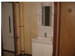
③洗面所へキャビネット型洗面化粧台設置(シングルバ-混合水栓付き)
