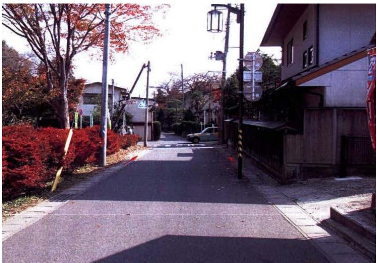
④白河市 (都：西郷溺目線) 円明寺工区整備
