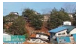
家屋被害：福島市
