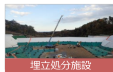
埋立処分施設
