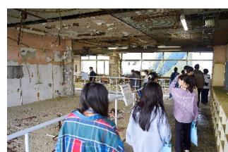
震災遺構浪江町立請戸小学校
