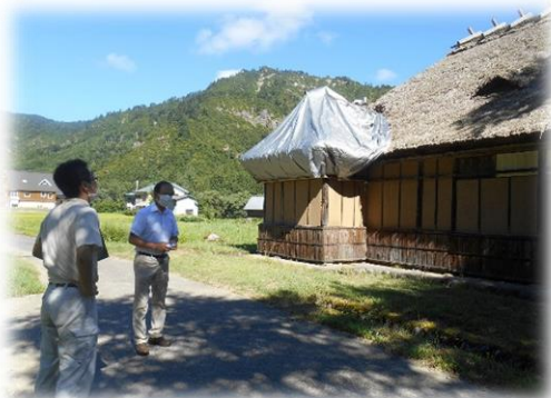
シートで覆われた屋根
