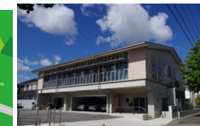
須賀川土木事務所 庁舎として東北初の「Nearly ZEB」認証を取得。エネルギー消費量の87%削減を実現。
