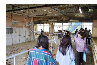
震災遺構浪江町立請戸小学校
