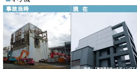
3月15日水素爆発により上部が大きく破損した。原子炉建屋回りに力バーを設置し、燃料取り出し完了。
