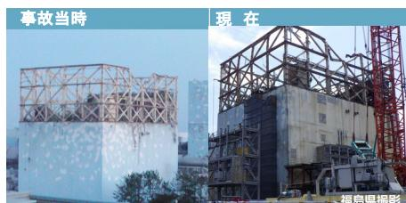
3月12日水素爆発によりがれき等が散乱した。現在は、がれき撤去のための大型力バー設置作業が進む。
