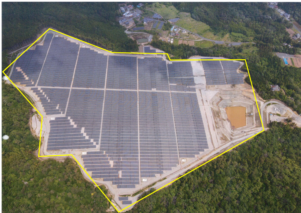
参考：航空写真（設置後）
