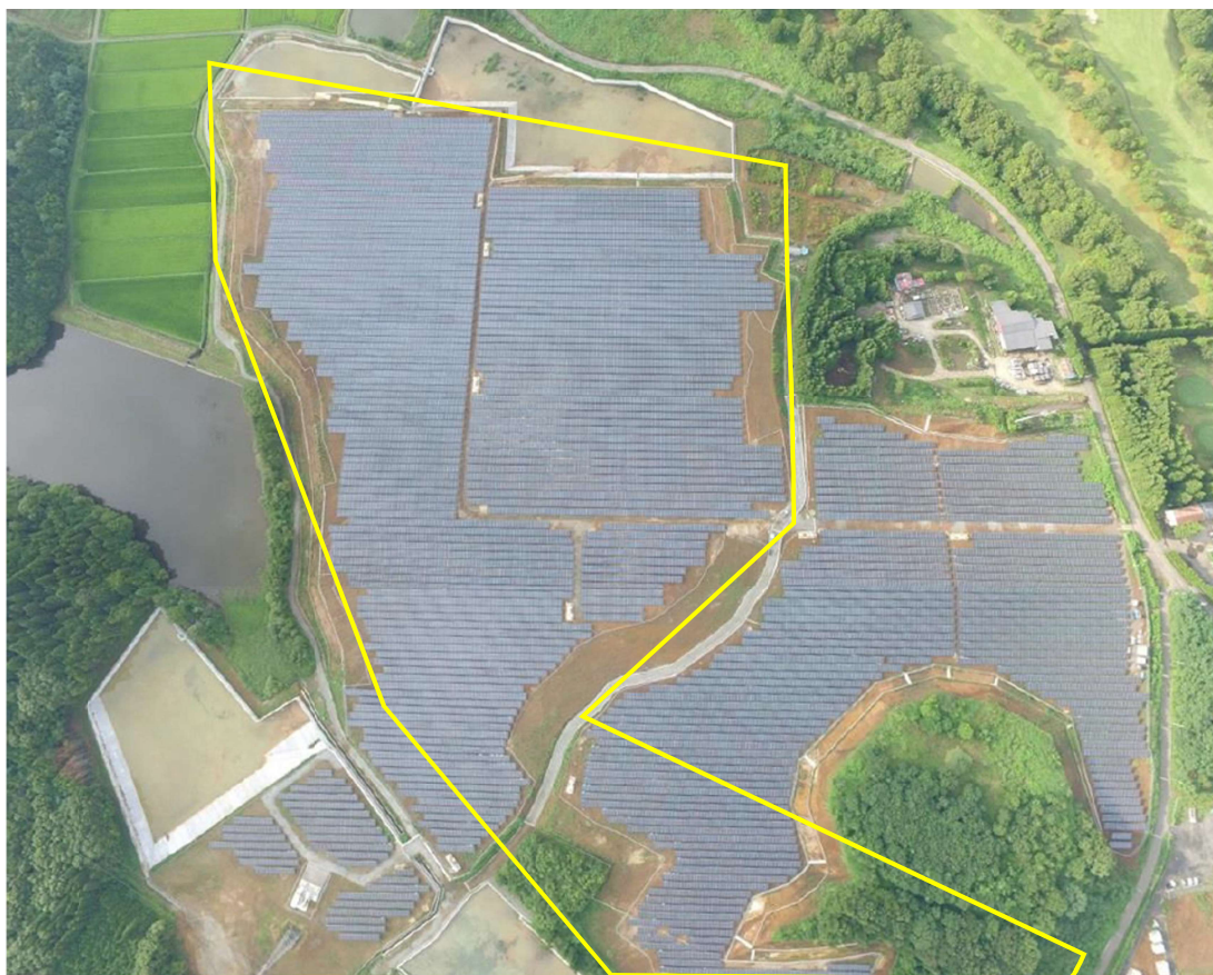
参考：航空写真（設置後）
