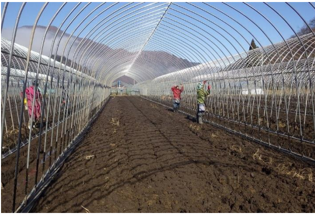
写真1 パイプハウス設営の様子
