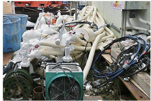
2号機海水配管トレンチ止水工事状況
