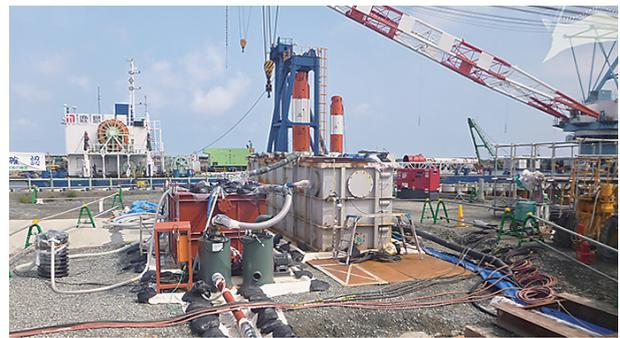
ウェルポイントによる汚染地下水汲み上げ
