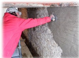
沢又橋 断面修復状況
