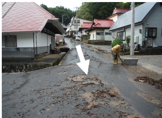
出水状況(平成30年9月)：②
