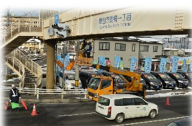
あさか歩道橋 点検状況
