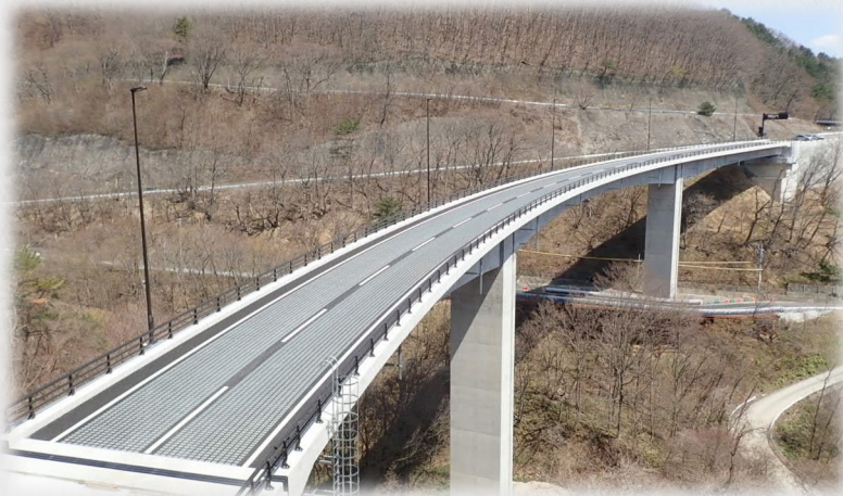
県道6号 郡山湖南線 三森I工区
