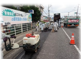
舗装修繕（パッチング）
