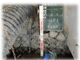
沢又橋 カゴマット中詰状況
