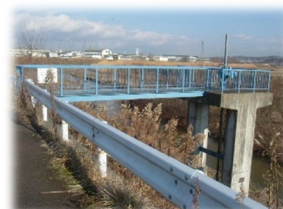
谷田川 北古川樋門
