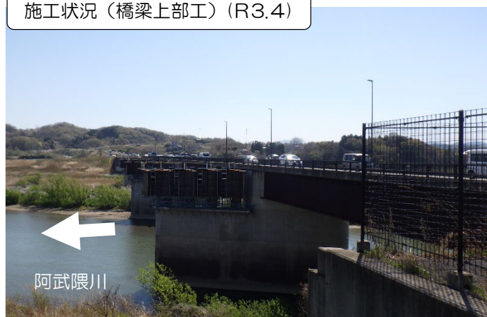
施工状況（橋梁上部工）(R3.4)
