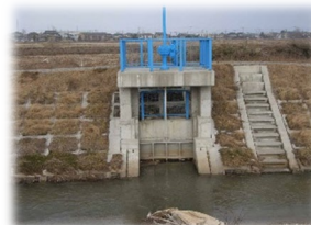
南川放水路 南川水門
