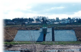
谷田川 江下3号樋門
