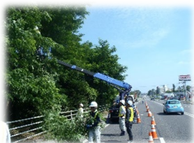
道路支障木伐採
