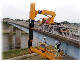
横塚橋 点検状況
