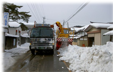
除雪（排雪）中状況
