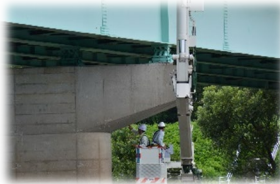
阿久津橋 点検状況
