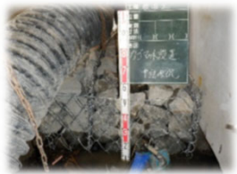
沢又橋 カゴマット中詰状況
