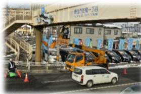
あさか歩道橋 点検状況
