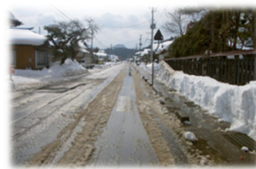
除雪（排雪）後状況
