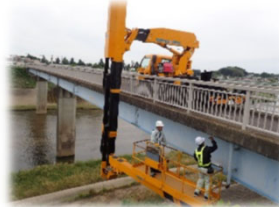
横塚橋 点検状況
