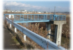
谷田川 北古川樋門
