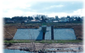
谷田川 江下3号樋門
