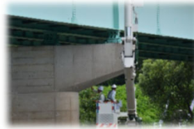
阿久津橋 点検状況
