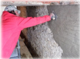
沢又橋 断面修復状況
