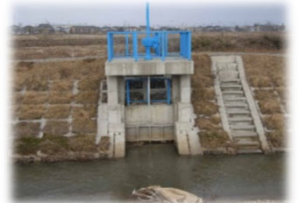
南川放水路 南川水門
