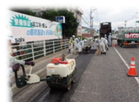
舗装修繕（パッチング）
