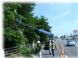
道路支障木伐採
