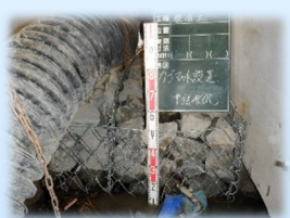
沢又橋 カゴマット中詰状況
