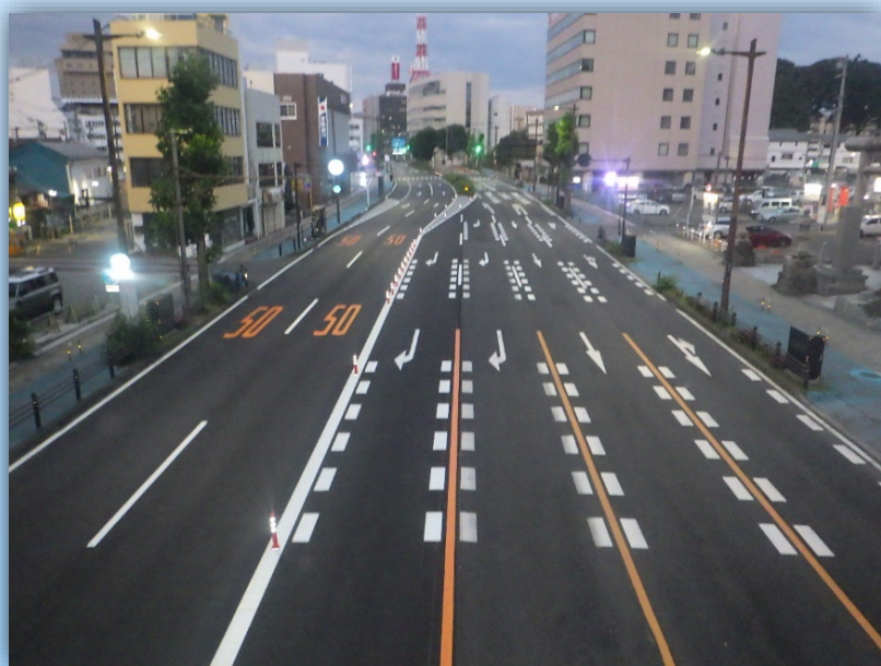
郡山停車場線（舗装補修） 令和4年6月28日完成
