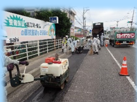
舗装修繕（パッチング）
