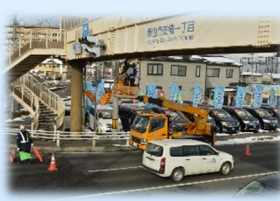
あさか歩道橋 点検状況
