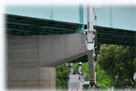
阿久津橋 点検状況
