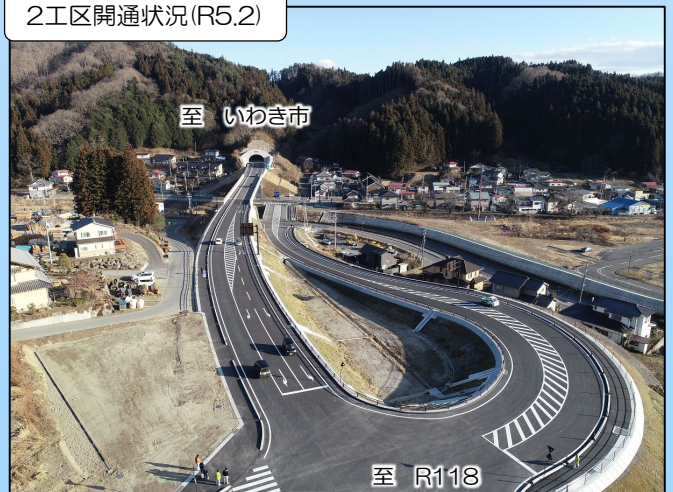
2工区開通状況(R5.2)
