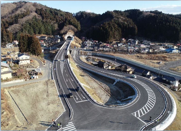
いわき石川線 石川バイパス2工区 令和5年2月25日開通
