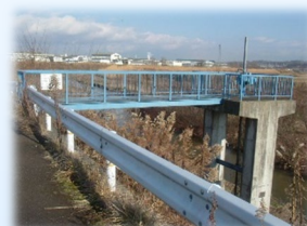
谷田川 北古川樋門
