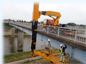
横塚橋 点検状況
