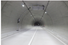
トンネル内の様子
