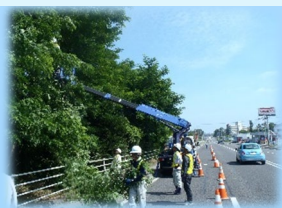
道路支障木伐採
