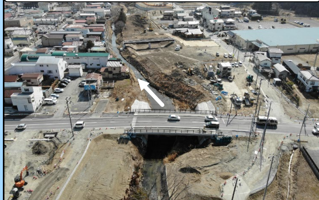
現場状況：小野橋付近と右支夏井川の改修状況(R5.3)
