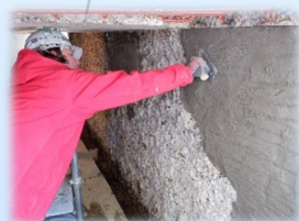
沢又橋 断面修復状況
