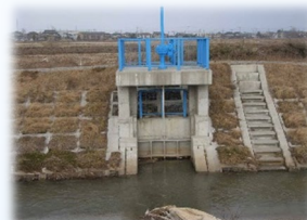
南川放水路 南川水門
