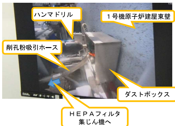
(写真2) アンカー削孔作業の状況①
