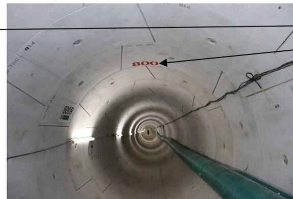
水中ドローンによる点検のため、トンネル内の天端部分に距離のナンバリング（特殊塗料）を実施
