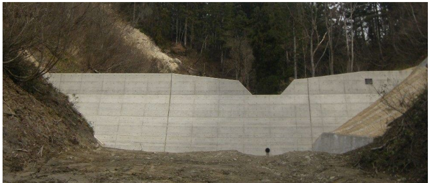
治山事業による荒廃溪流の復旧(只見町田ノ口沢地区)
