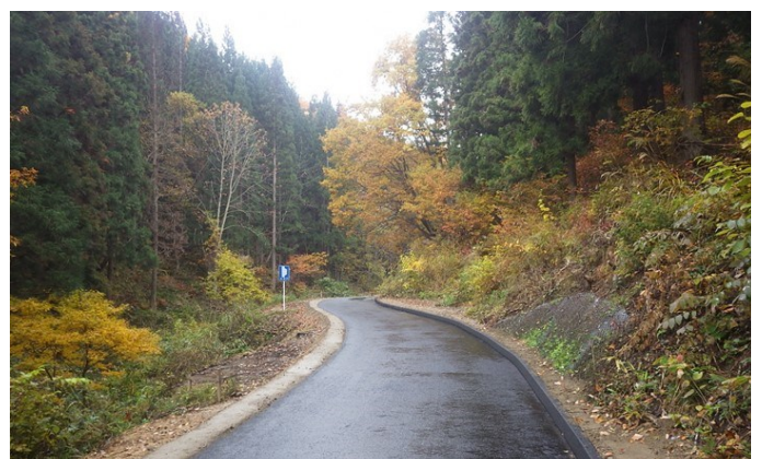
林業専用道「小塩麻布支線」(南会津町)
