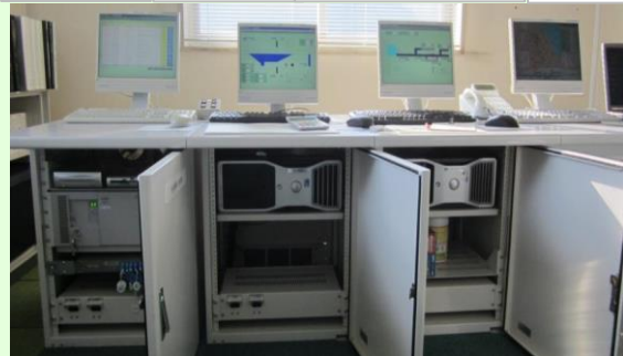
ダム管理用制御処理装置改良工事
