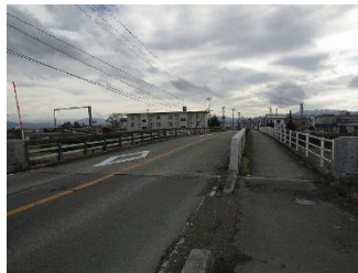
②補修箇所の確認
