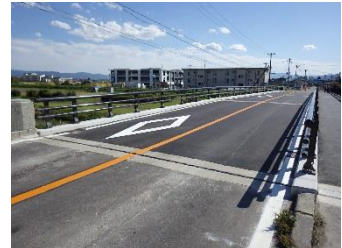
③補修施工を行い完了
