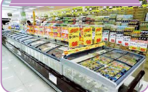
フロン不使用冷ケース
