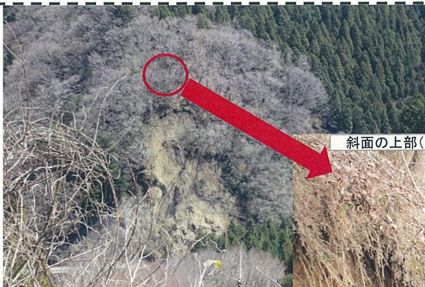
斜面の上部(H=40m)にはこのような亀裂が有ります
