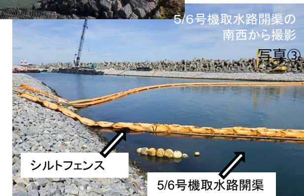
5・6号機海側工事エリアの状況
