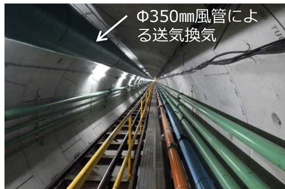
酸素欠乏症対策の坑内換気
