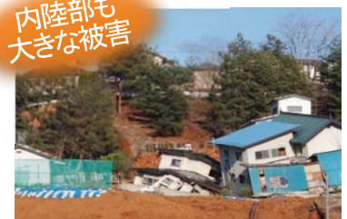
家屋被害の状況（福島市伏拝地内）
