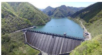
新宮川ダム(会津美里町)
