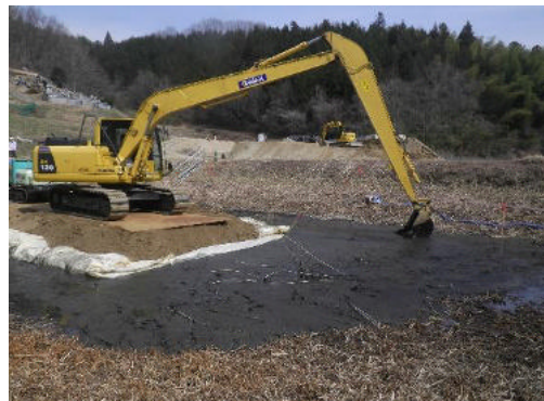
(例)ため池底質の掘削除去状況
