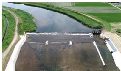
頭首工の整備【栗村堰(会津坂下町 会津美里町)】
