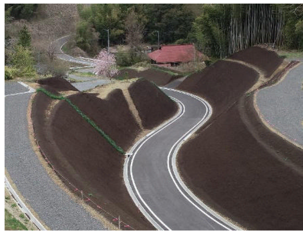
基幹農道整備事業 中石井3期地区（矢祭町）
