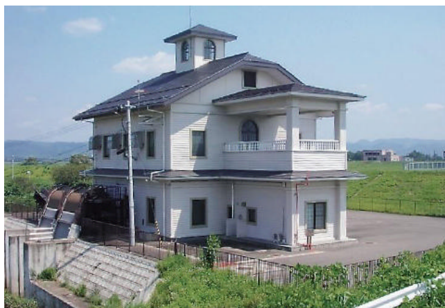
だんざき 伊達崎排水機場（桑折町）
