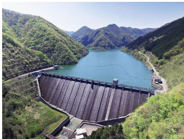
新宮川ダム（会津美里町）
