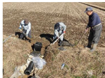
多面的組織での落水堰設置状況
