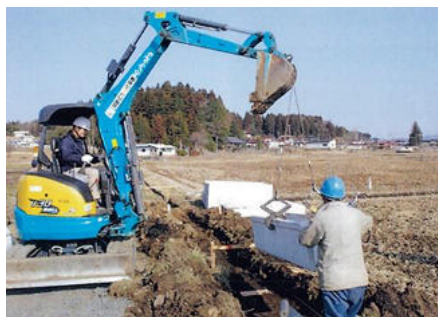
直営施工による水路整備
