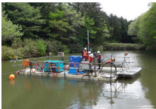
(例)ポンプ浚渫による除去状況
