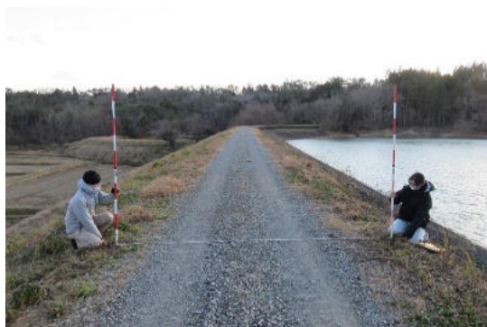
ため池堤体の劣化状況の調査
