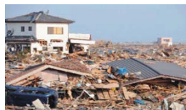
津波被害：浪江町
