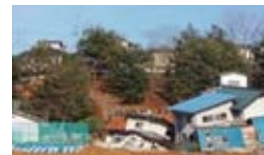
家屋被害：福島市
