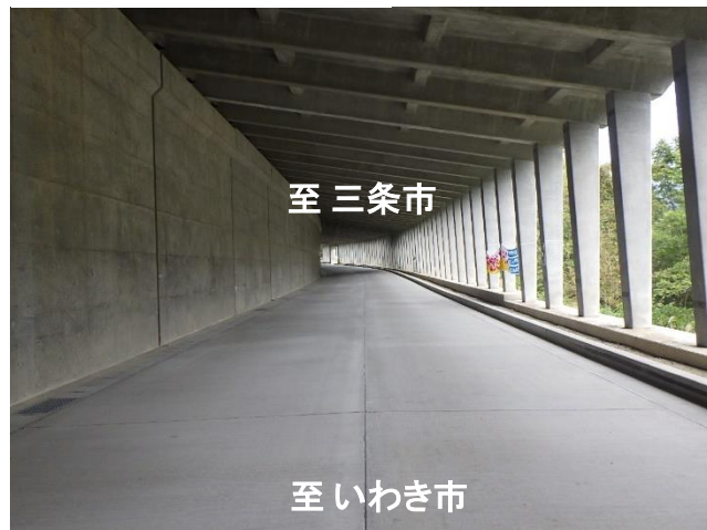
スノーシート工事状況
