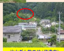
治山ダム施工地(伊達市)
