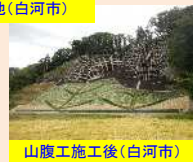
山腹工施工後(白河市)
