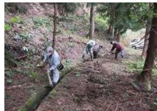
中山間地域等直接支払事業 水路掃除の様子
