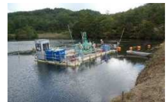
実施例④ ポンプによる浚渫除去
