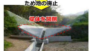
ため池廃止の施工例
