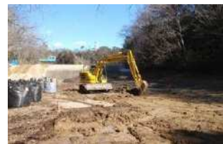
実施例③ 底質の掘削除去
