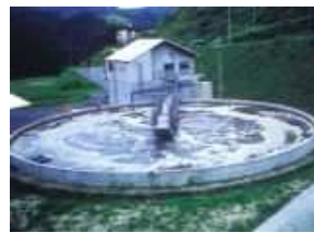
畜産環境対策施設
