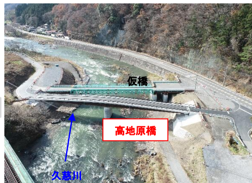
※仮橋撤去中(矢祭町発注工事)
