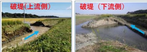
(被災概要等) ・延長73.1mが破堤 (上流52.1m,下流21.0m)
