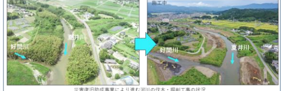
災害復旧助成事業により進む河川の伐木・掘削工事の状況
