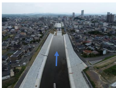
逢瀬川 河川改修
