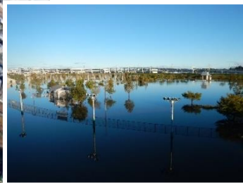
台風第19号時の貯留状況
