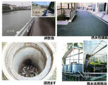
雨水貯留浸透施設の例
