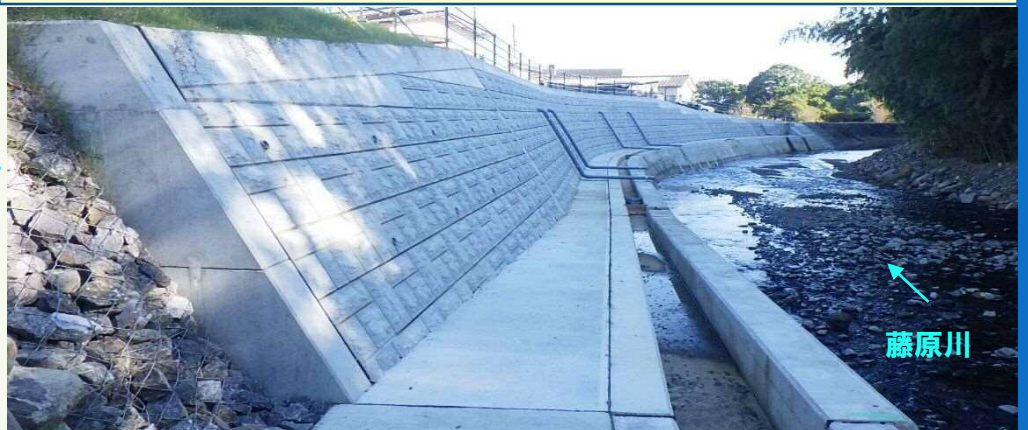
護岸工事 (完了)
