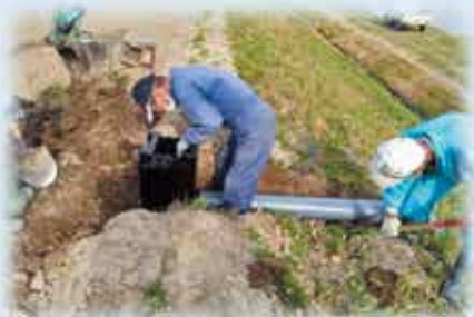
排水口の整備
