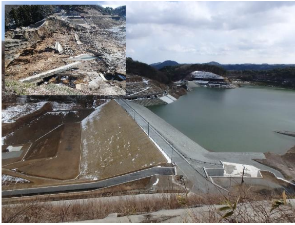
東日本大震災で決壊した藤沼湖の復旧 ※左上:被災時の状況
