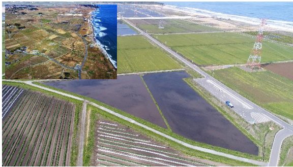
ほ場整備原町東地区(南相馬市)※左上:整備前の状況
