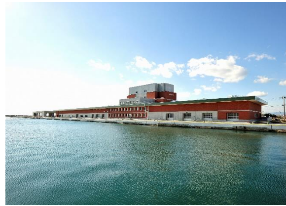
東日本大震災からの復旧(小名浜魚市場)
