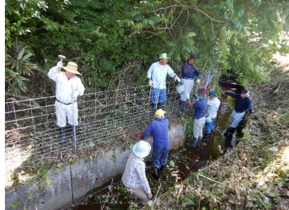
ワイヤーメッシュ柵設置(会津若松市赤井)
