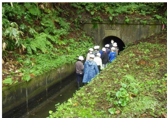
歴史ある農業水利施設の見学(戸ノ口堰洞門めぐり)
