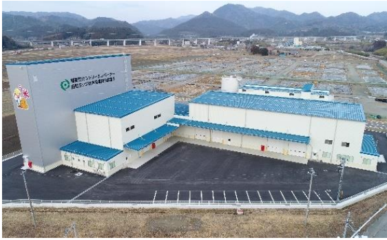
営農再開に向けた施設整備 (カントリーエレベーター)
