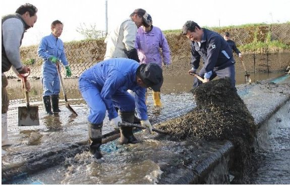
地域ぐるみでの堰の土砂上げ作業
