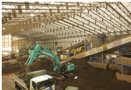
受入・分別施設(運転中)
