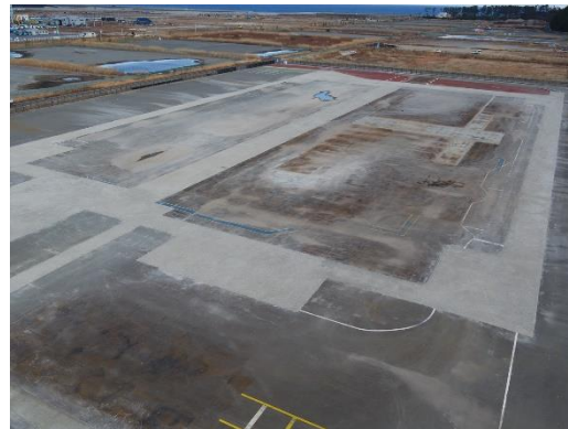
受入・分別施設(解体完了)
