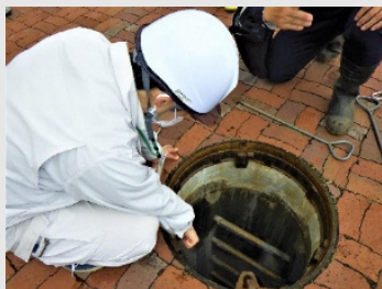
▲ マンホール点検 木の根が詰まることも…
