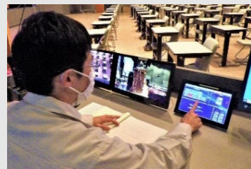
▼ 講堂 AV 機器操作 工事で最新機器に更新
