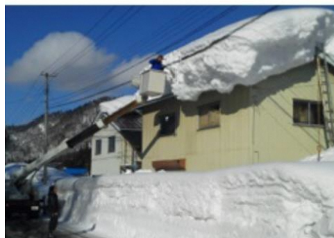
図4：高所作業車による屋根の雪下ろし
