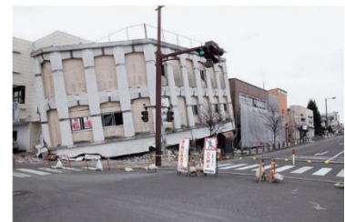
▲地震で倒壊した建物（須賀川市）
