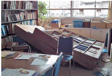
▲本棚の転倒（盲学校）
