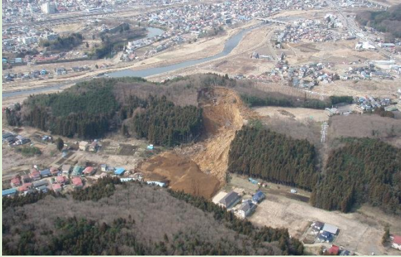
▲東日本大震災時の土砂崩れ（白河市葉ノ木平）
