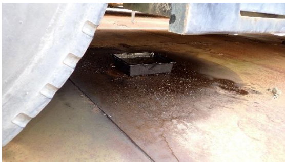
(写真3-2) ラフタークレーン②下部に設置された受けパンの状況
