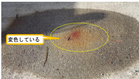
(写真1-2) ラフタークレーン①下部の状況
