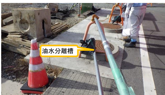
(写真6) 油水分離槽の状況
