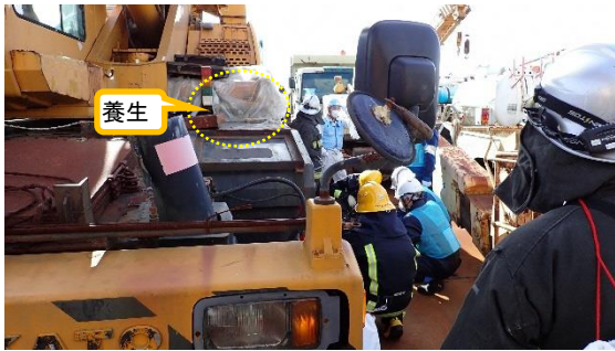
(写真3-1) ラフタークレーン②の確認状況
