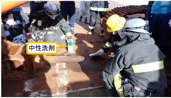
(写真4-2) バックホー①アーム下部の確認状況
