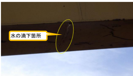
(写真4-1) バックホー①アーム下部の状況
