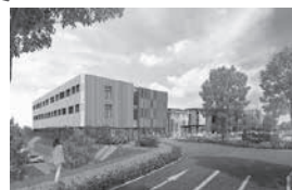
ふくしま医療センターこころの杜(令和4年10月開院予定)
