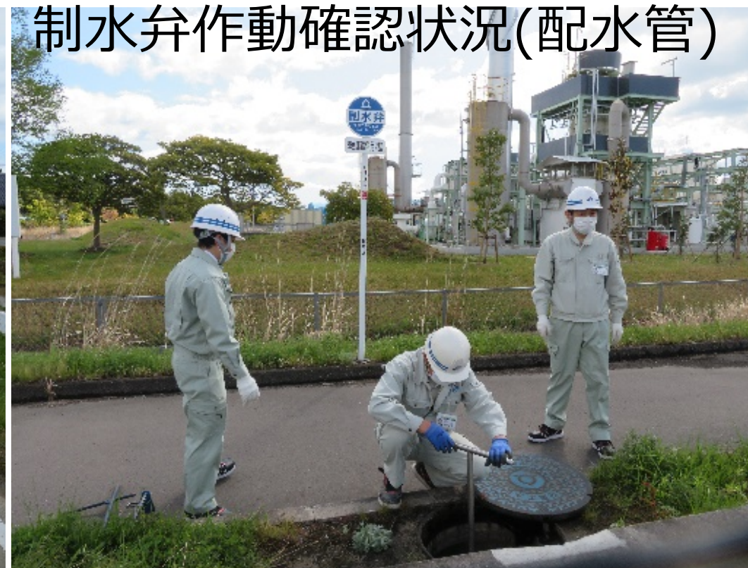
制水弁作動確認状況(導水管)
