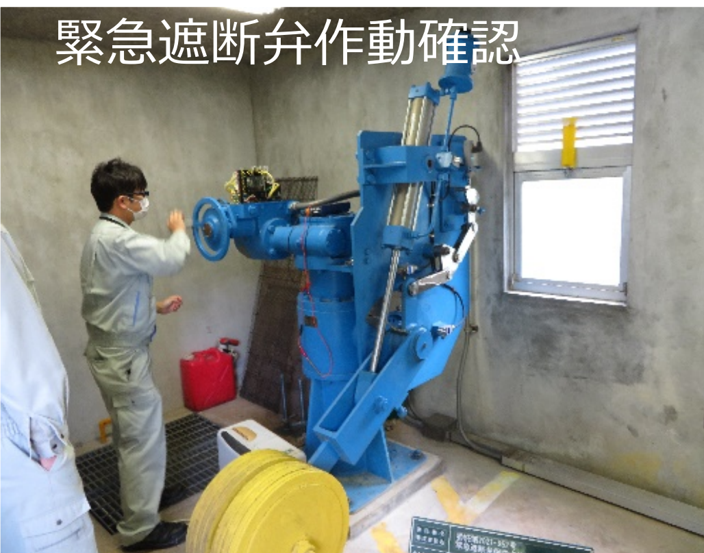
制水弁作動確認状況(導水管)
