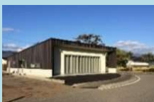
猪苗代水環境センター (猪苗代町)
