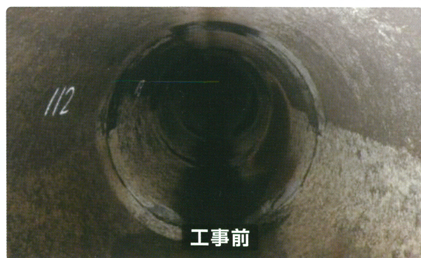
とみかわかんせん ようすい ろ 富川幹線用水路 (会津若松市北会津町真宮地区)
