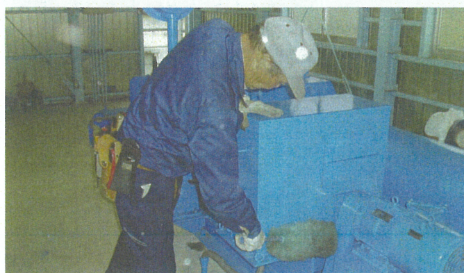
馬越取水口巻上機点検
