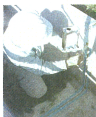
施設補修の状況
