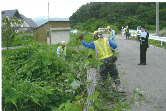
本郷発電所付近
