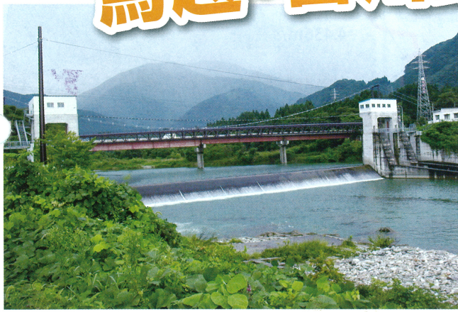
馬越頭首工(昭和63年に完成)
