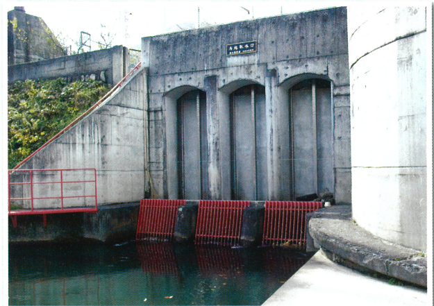
馬越頭首工左岸取水ゲート(一定した水を取り入れます)
