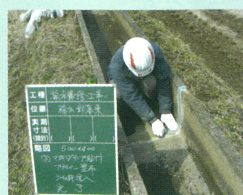
施設補修の状況
