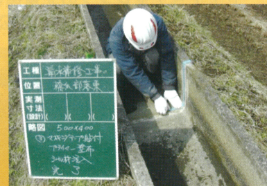
水路を直しているところ
