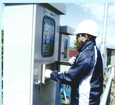
ゲートの調節をしているところ
